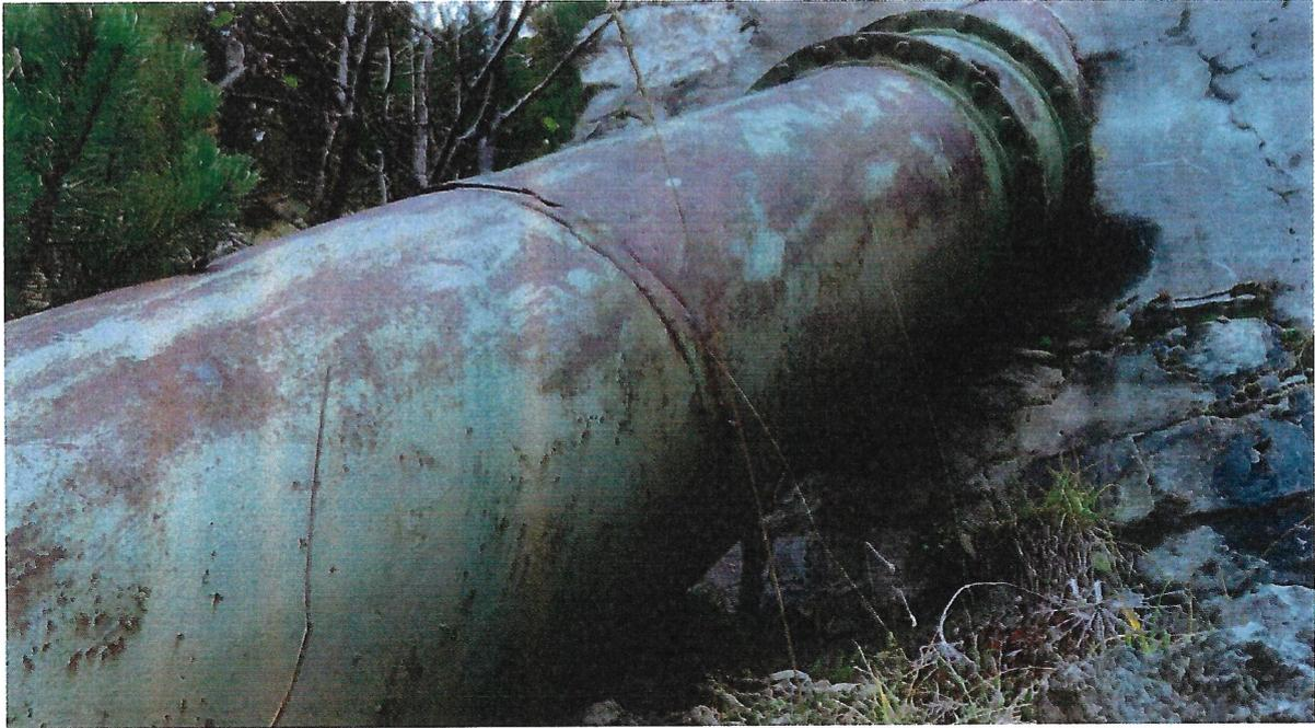
Abbildung 5: Anschluss Druckleitung an Wasserschloss (in Bildmitte Riss in Druckleitung ersichtlich)
