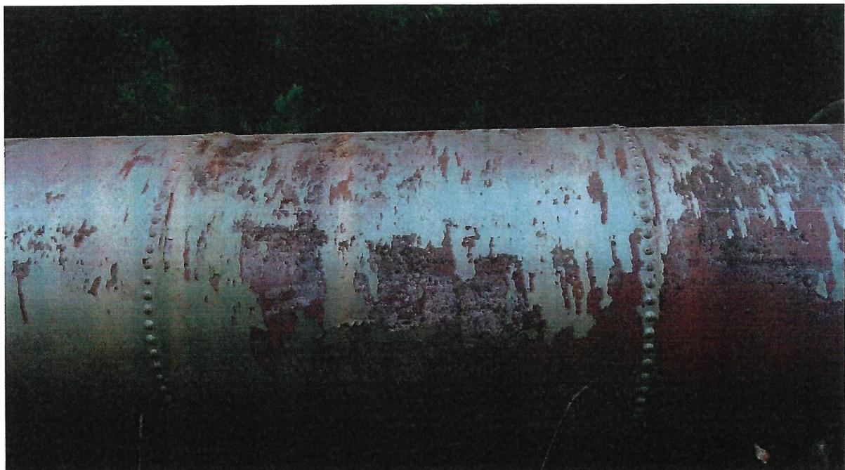
*Abbildung 4: abgeblätterter Aussenkorrosionsschutz Hangleitung*
