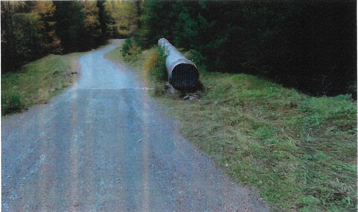
*Abbildung 3: Abgetrennte Hangleitung Richtung Wasserschloss gesehen*
